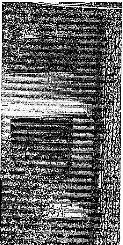
Udvart tornác falazott, vakolt felületű, fejezetes tornácoszlopokkal
